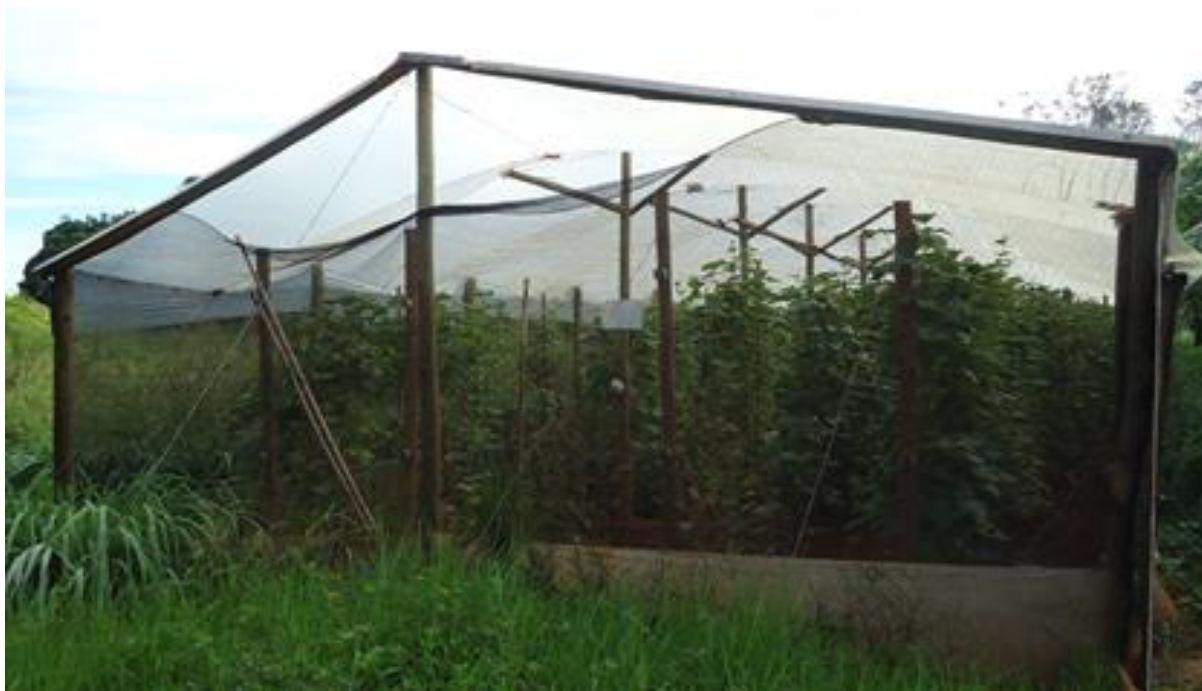
Figura 30. Estrutura para cultivo protegido, modelo duas águas/Capela, município de Uraí-PR.
