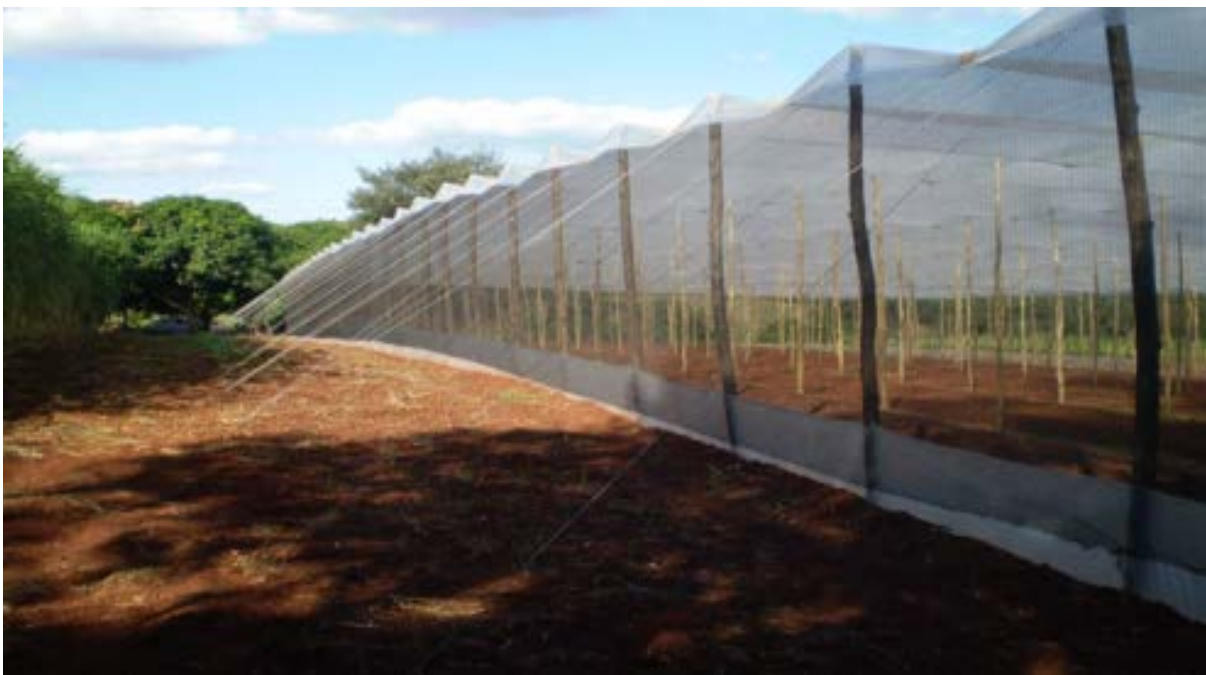
Figura 26. Estruturas para cultivo protegido, modelo Bandeirantes, idealizado por agricultores do município de Bandeirantes – PR; detalhamento do sistema de fixação externo (rabicho e ou sapata).
