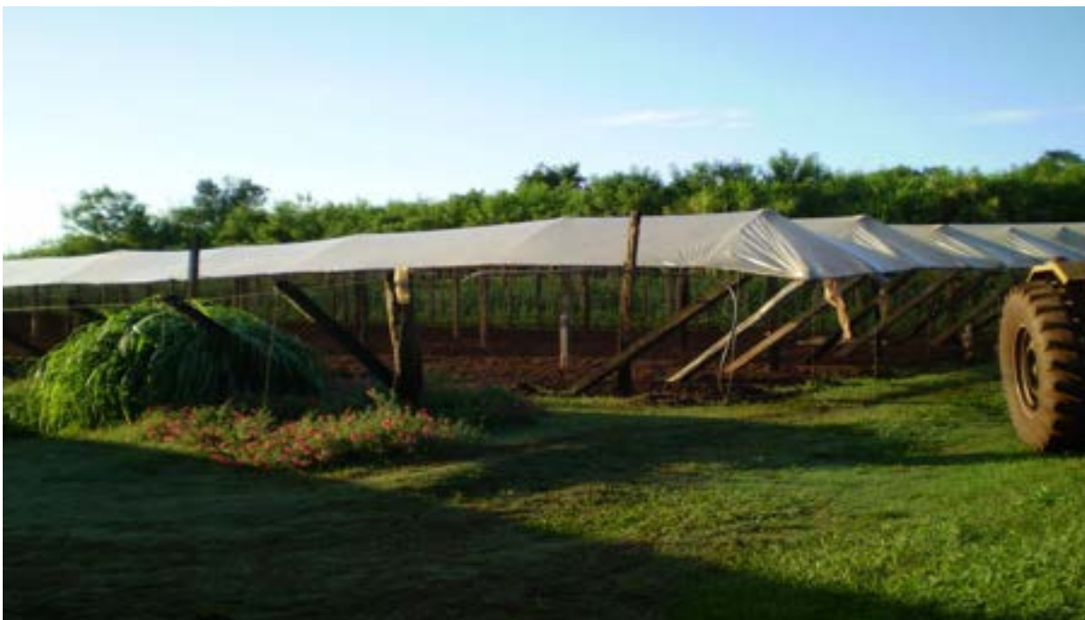
Figura 22. Estrutura para cultivo protegido, modelo adaptado em estrutura de parreira de Uva de Mesa em sistema latada, município de Uraí – PR.
