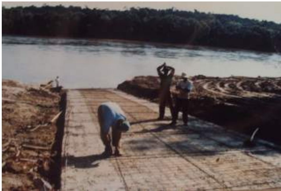
Imagem 17 – Construção da rampa náutica. Fonte: Acervo Anísio Furlan.
