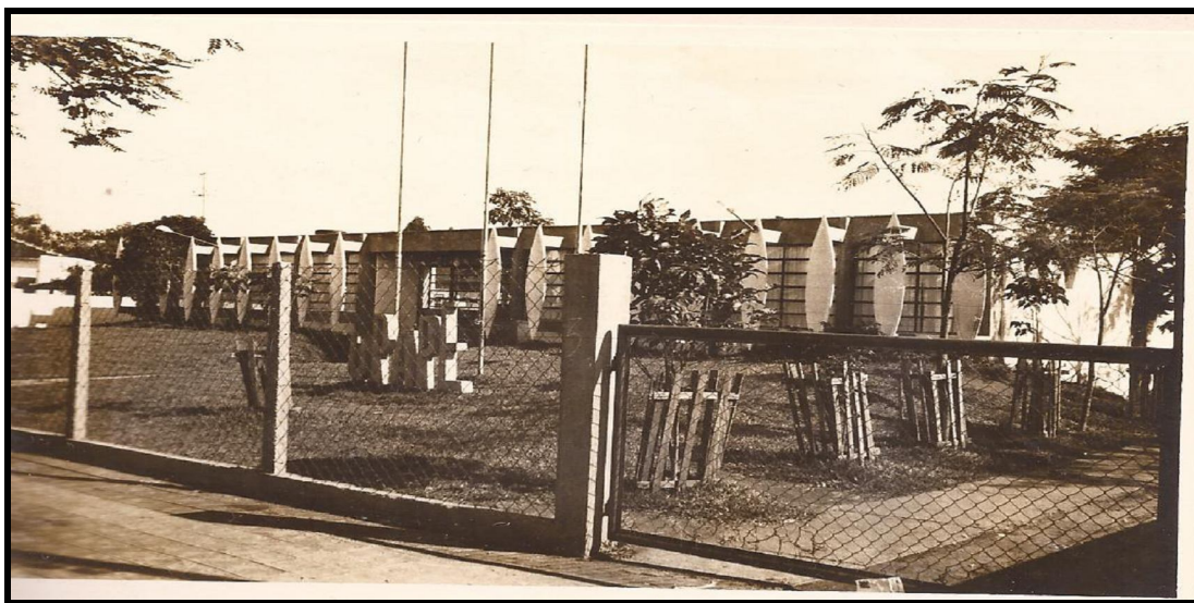
Figura 17 – Fachada e entrada principal da UPAE – 1974
