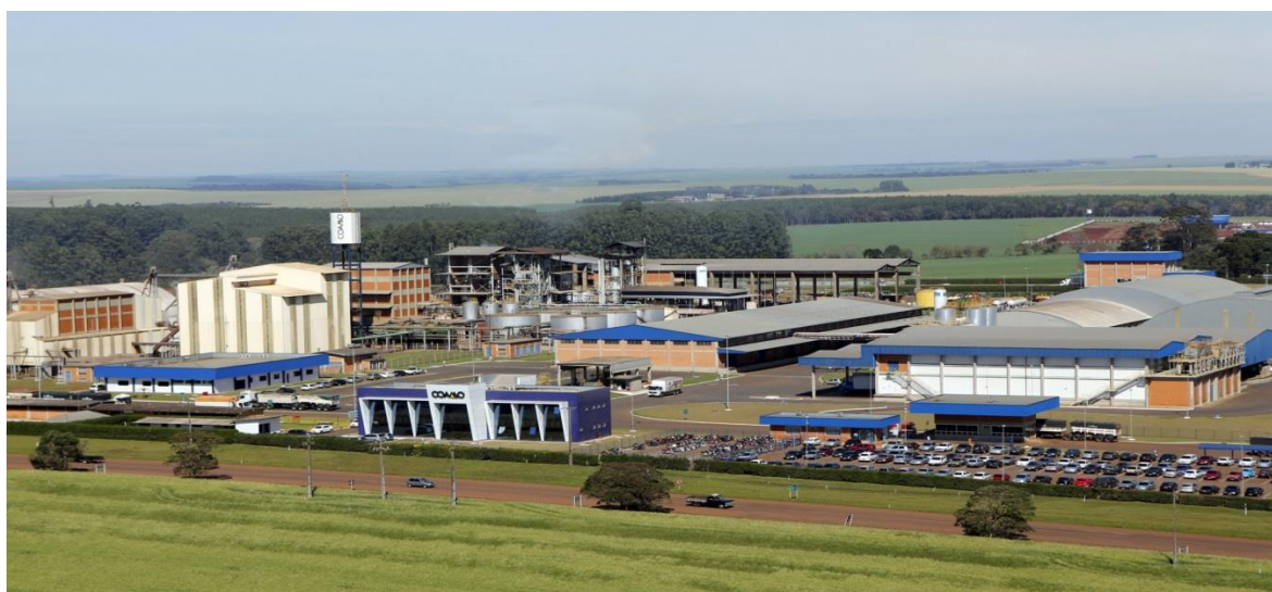
Figura 11 – Parque Industrial da Coamo em Campo Mourão/PR
