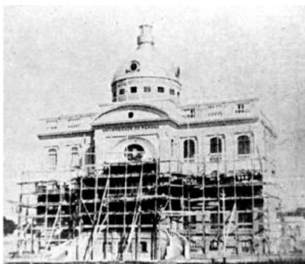
Figura 3 - Prédio Histórico da Universidade do Paraná
