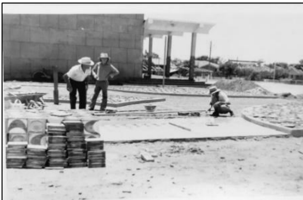
Figura F. a – Construção Igreja Matriz
