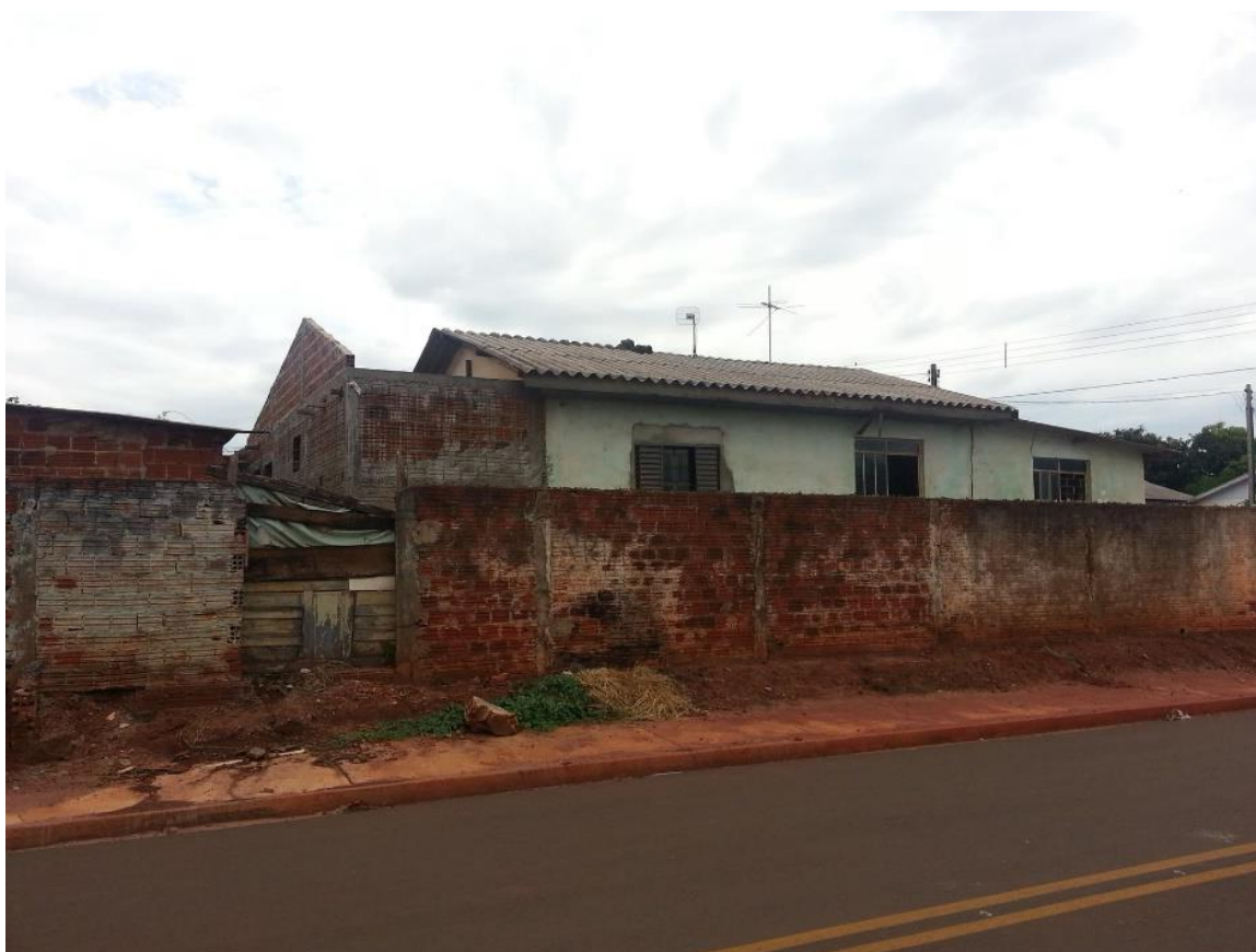
Figura 4 - Presença de autoconstruções em Jardim Universitário.
