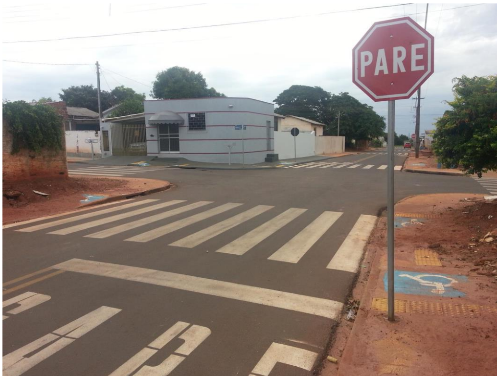
Figura 11 - Rua Profª Cremilda V Pastorello: asfalto e sinalização
