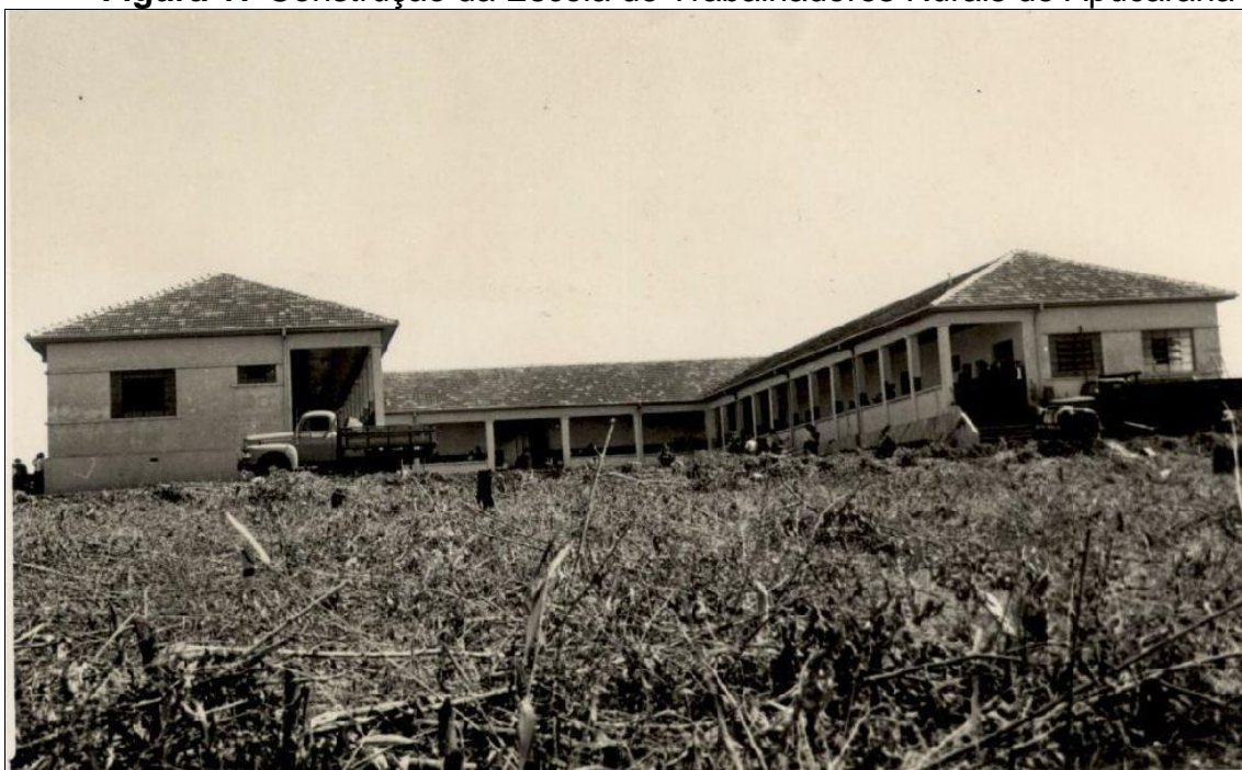
Figura 17 Construção da Escola de Trabalhadores Rurais de Apucarana
