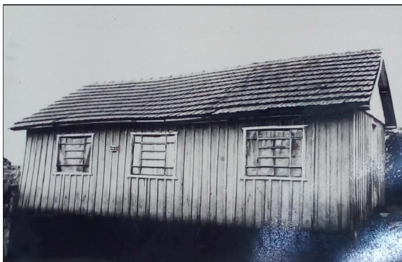
Figura 14 Escola Rural Ana Nery – Construída em 1957
