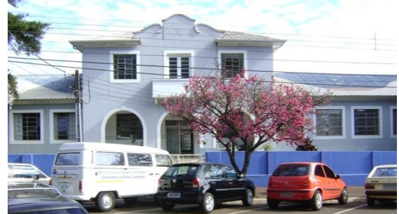
Figura 7 Fachada do Colégio Alberto Santos Dumont (2018)
