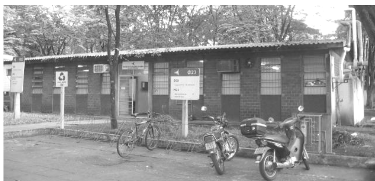
Foto 6.1.13 – Bloco Didático/Administrativo PQU [2005].
