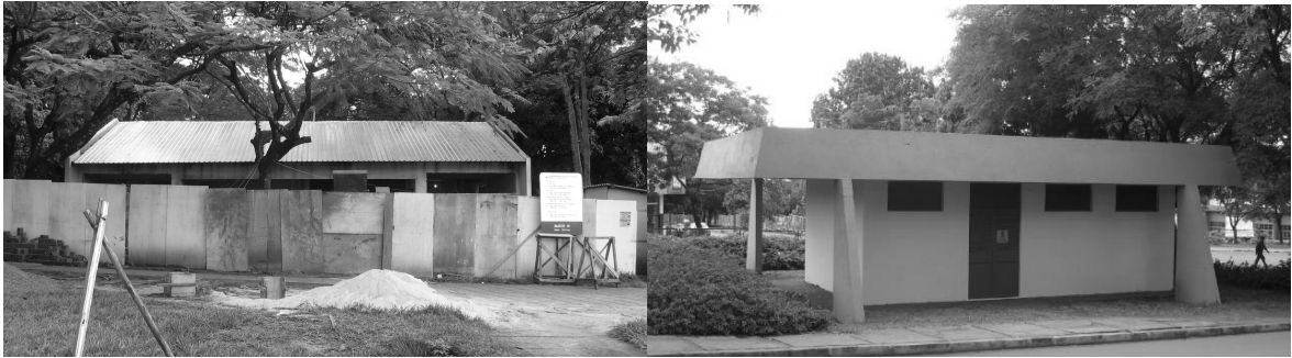
Fotos 6.1.25 e 6.1.26 – Bloco 039 (I.S) e Bloco Q01 (Posto de Medição) [2005].
