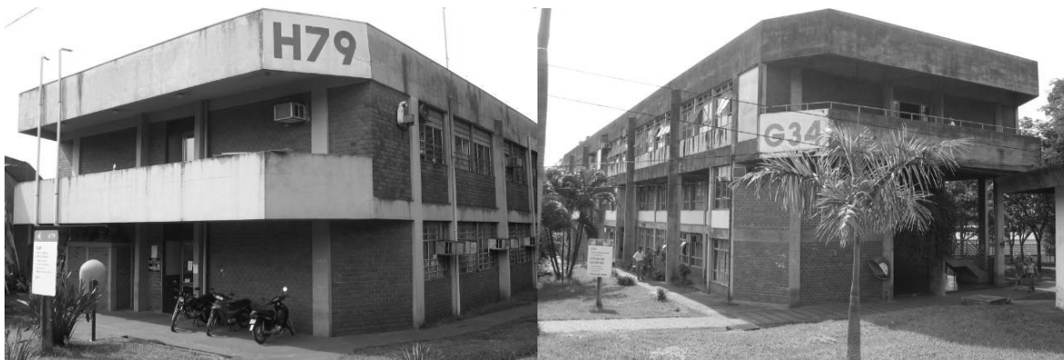
Fotos 6.2.19 e 6.2.20 – Bloco H79 (Laboratórios DCM) e Bloco G34 (Didático/Administrativo CCH) [2005].
