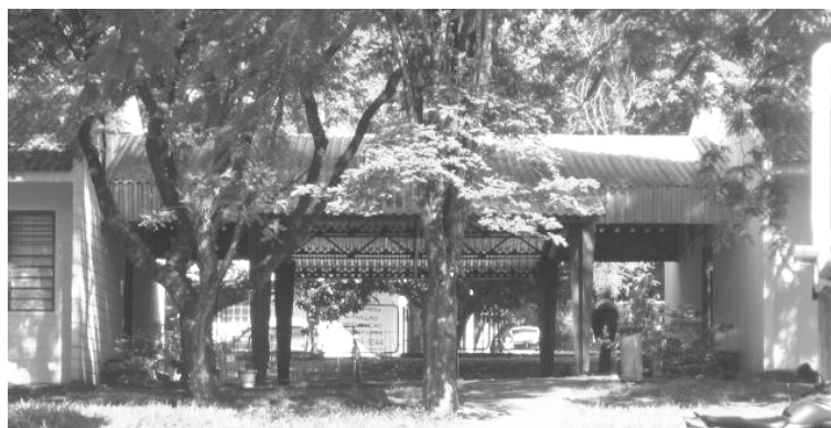
Foto 6.1.16 – Pátio coberto entre os Blocos 029 (à direita) e 030 (à esquerda) [2005].
