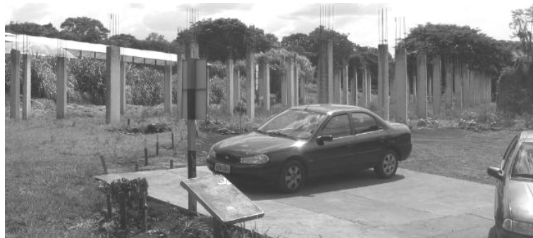
Foto 5.3.6 – Estruturas do Bloco J45 ao lado do Bloco J57 [2005].
