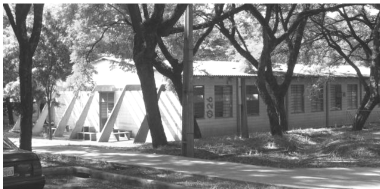
Foto 6.1.14 – Bloco 026 (Salas de aula) [2005].
