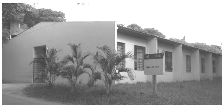
Foto 6.1.15 – Bloco 038 (Salas de aula) [2005].
