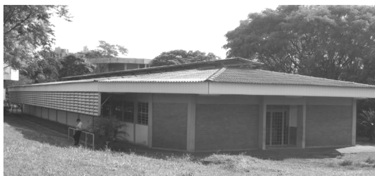
Foto 6.2.16 – Blocos G68 (Laboratórios e Salas de aula DFI) [2005].
