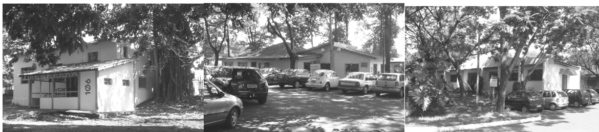
Fotos 5.3.1, 5.3.2 e 5.3.3 – Bloco 106 (Casa da Dança), Bloco 115 (Administrativo PPG) e Bloco 117 (Casa da Música). Fonte: Acervo do autor [2005].
