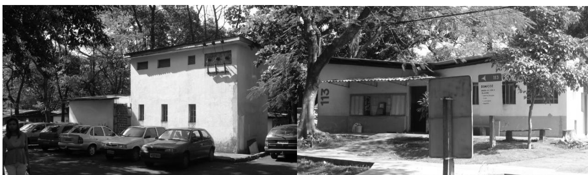
Fotos 6.1.21 e 6.1.22 – Bloco 108 (Subestação Transformadora) e Bloco 113 (DSM e Cozinha) [2005].
