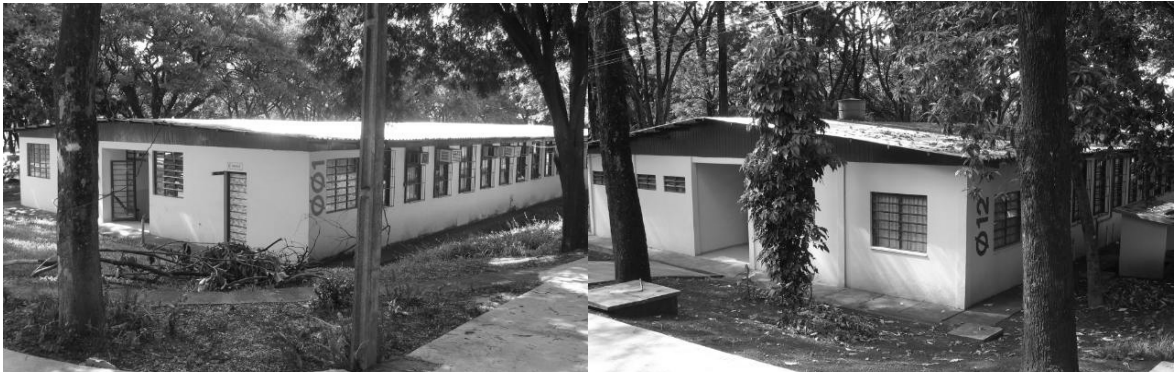
Fotos 6.1.17 e 6.1.18 – Bloco 001 (Did./Adm. DEN e Laboratório) e Bloco 012 (Did./Adm. DEC) [2005].
