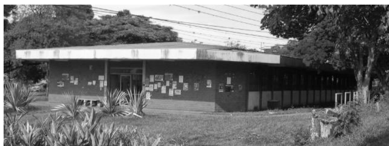
Foto 6.2.8 – Bloco E34: Salas de aula do Centro de Ciências Sociais Aplicadas (CSA).
