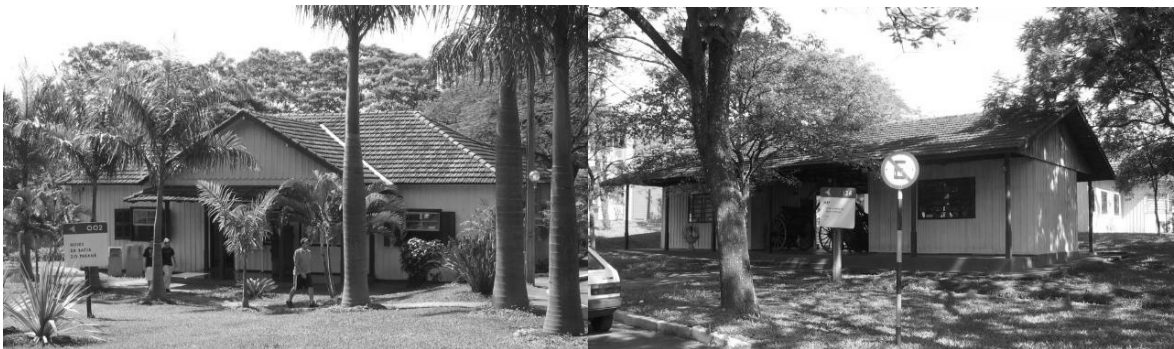
Fotos 6.1.19 e 6.1.20 – Bloco Q02 (MBP) e Bloco 124 (Salão de Exposição do MBP) [2005].
