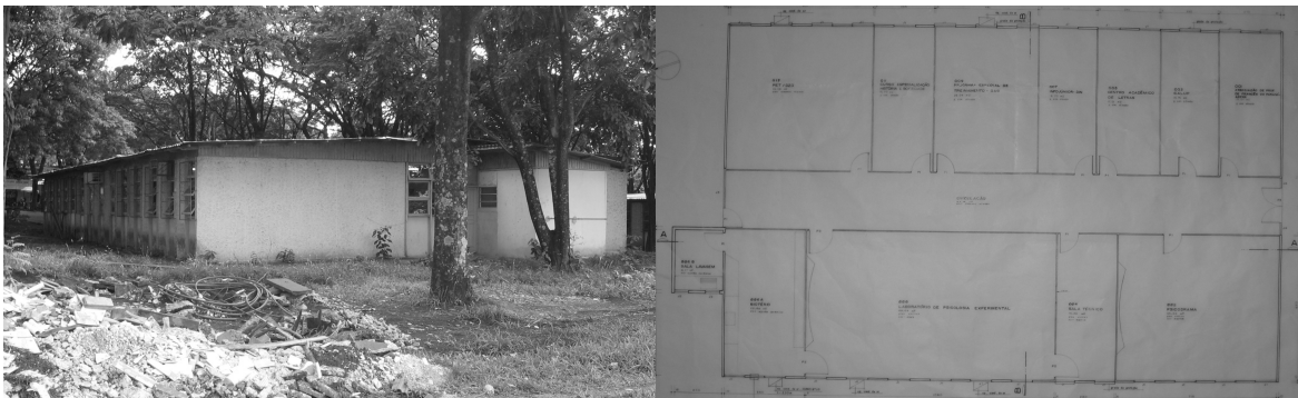
Fotos 6.1.7 e 6.1.8 – Bloco 007 (Face sul com anexo/Planta com Sala de Lavagem do Biotério).
